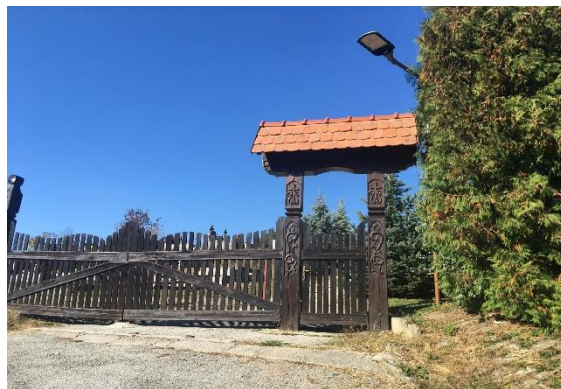
Obr. 23 - OBNOVA PRESTREŠENIA NAD VCHODOM DO CINTORÍNA
