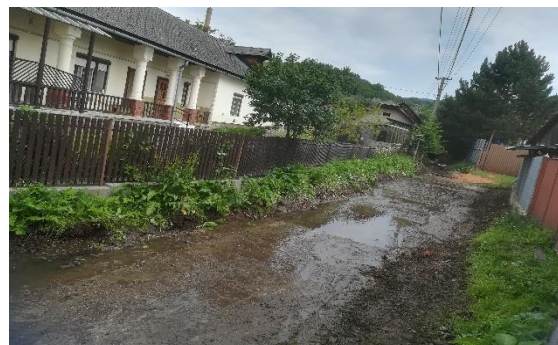
Obr. 32 - VYČISTENIE KORYTA POTOKA DEMÁRKA
