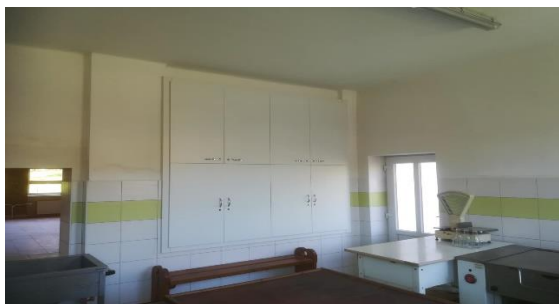
Obr. 29 - REKONŠTRUKCIA PRIESTOROV KUCHYNE OÚ
