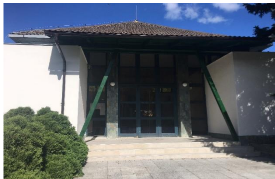
Obr. 15 - OBNOVA DOMU SMÚTKU – PRESTREŠENIE, SCHODY, FASÁDA
