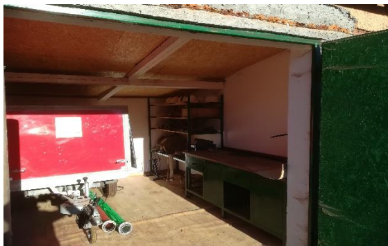
Obr. 28 - PRETVORENIE SKLADU DREVA V MŠ NA GARÁŽ PRE ULOŽENIE PROTIPOVOĎŇOVÉHO VOZÍKA
