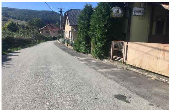
Obr. 19 - OPRAVA A ASFALTOVANIE CESTY V OBCI
