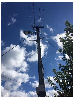
Obr. 27 - VÝMENA OSVETLENIA ZA LED SVIETIDLÁ A OSADENIE DRŽIAKOV PRE VIANOČNÉ OSVETLENIE V OBCI
