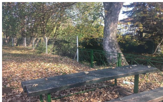
Obr. 17 - OPRAVA OPLOTENIA A STRECHY NA FUTBALOVOM IHRISKU
