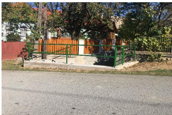
Obr. 21 - OSADENIE NOVÝCH ZÁBRADLÍ V OBCI
