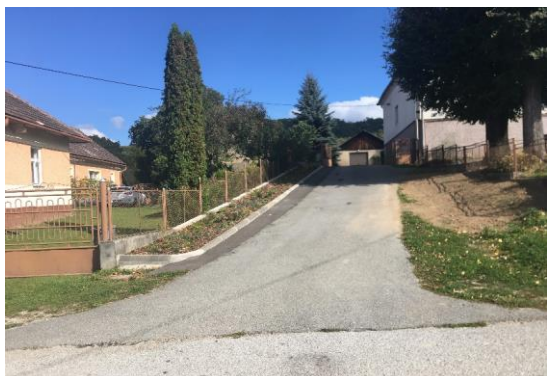
Obr. 22 - ASFALTOVANIE PRÍJAZDOVEJ CESTY KU KOSTOLU A REALIZÁCIA TRVALKOVÉHO ZÁHONU
