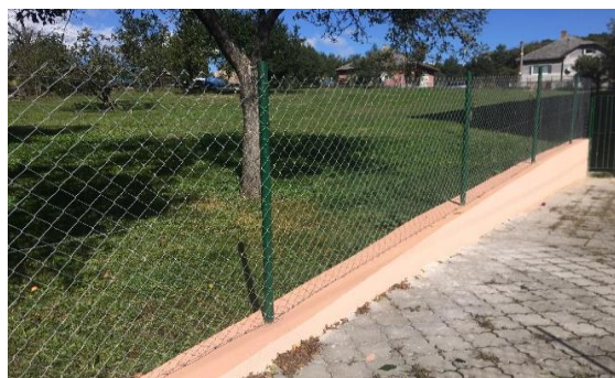
Obr. 16 - REALIZÁCIA NOVÉHO OPLOTENIA ZA KULTÚRNYM DOMOM
